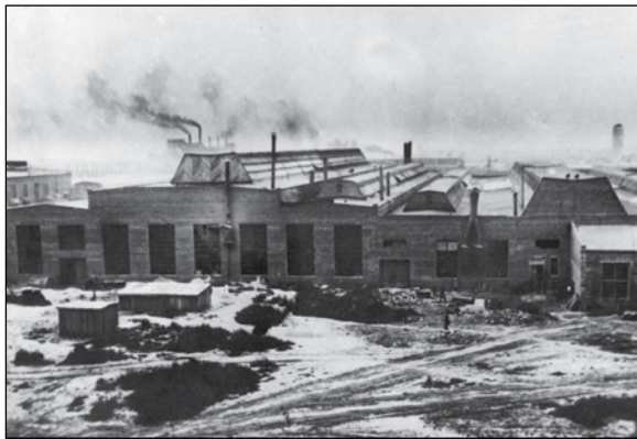
Строящийся корпус завода, зима 1942 г.
