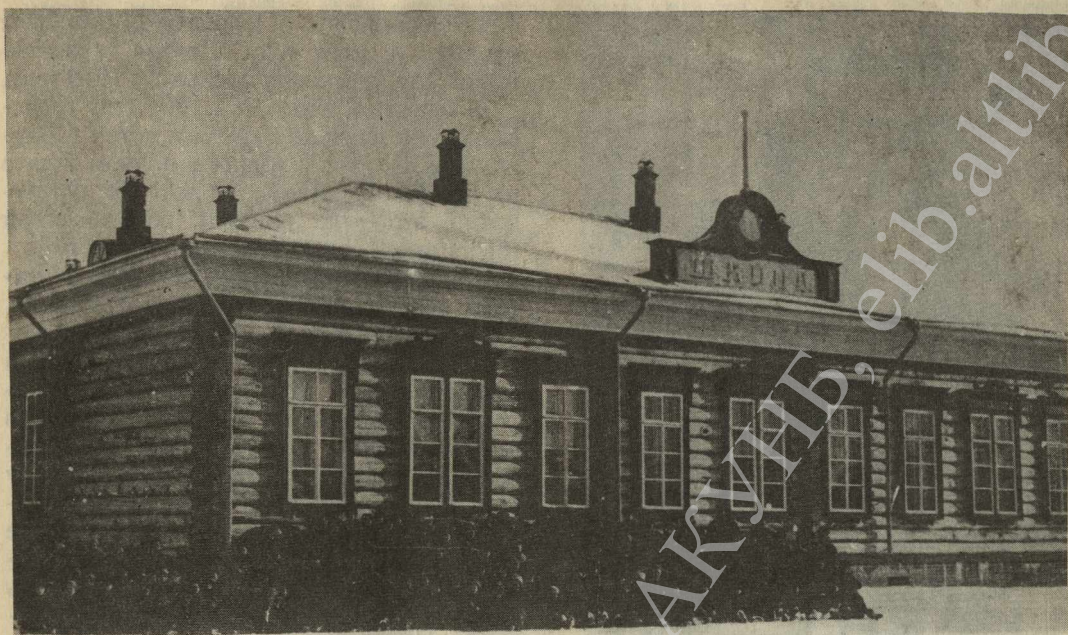
Зайчанская школа. Построена в 1891 г.
